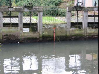
Observations: mauvais fonctionnement des pelles de vannes
