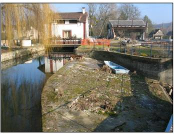
Observations: le 16/10/19, bon état de l'ouvrage de décharge amont, l'ouvrage du bras usinier présente une pelle de vanne dans un état moyen
