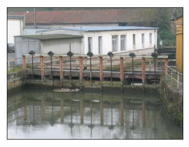
Observation: travaux d'entretien à réaliser (graissage des mécanismes, nettoyage devant le vannage, coupe d'arbustes qui gênent l'ouverture d'une pelle de vanne, retrait d'un arbre sous le pont amont) – visite du 15/10/19
