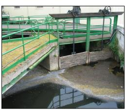
Remarque : le mécanisme de la première vanne est **Hors service**, l'ouverture doit se faire à l'aide d'un palan.
