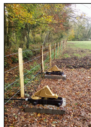
Pose de clôture et de pompes à nez
